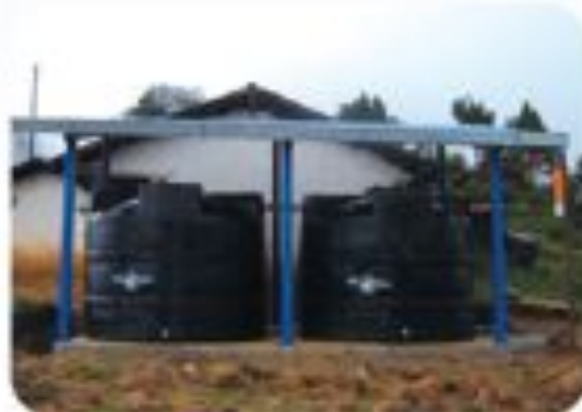
Fabricación de tejabanos para la captación de agua pluvial.
