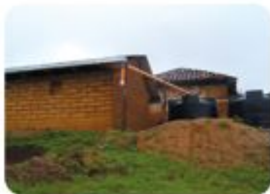
Aprovechamiento de techumbres en las viviendas.
